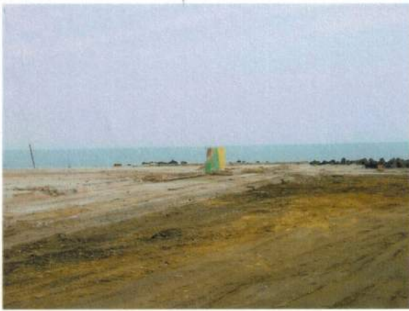
〈解体の済んだ久之浜第一幼稚園園舎跡地〉
